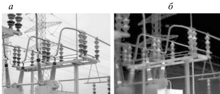
Рис. 3. Опорные изоляторы: a — фотография, б — термограмма
